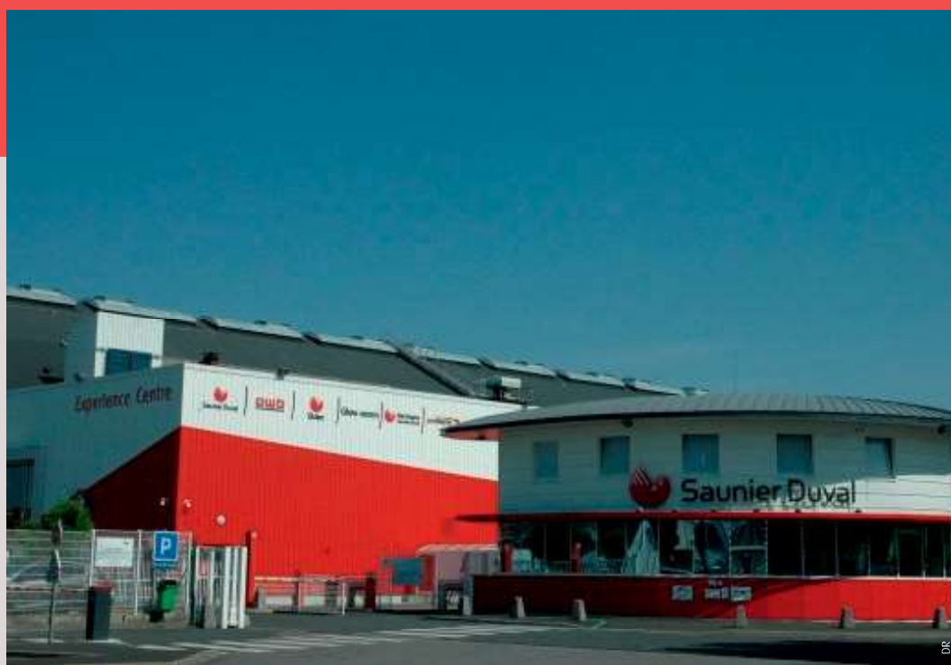
Entrée du site de l'entreprise, à Nantes, face aux parkings (à gauche).
